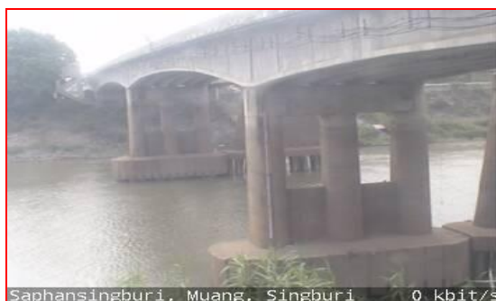
สถานีเขื่อนสะพานสิงห์บุรี ต.บางมัญ อ.เมือง จ.สิงห์บุรี (ลุ่มน้ำเจ้าพระยา)
